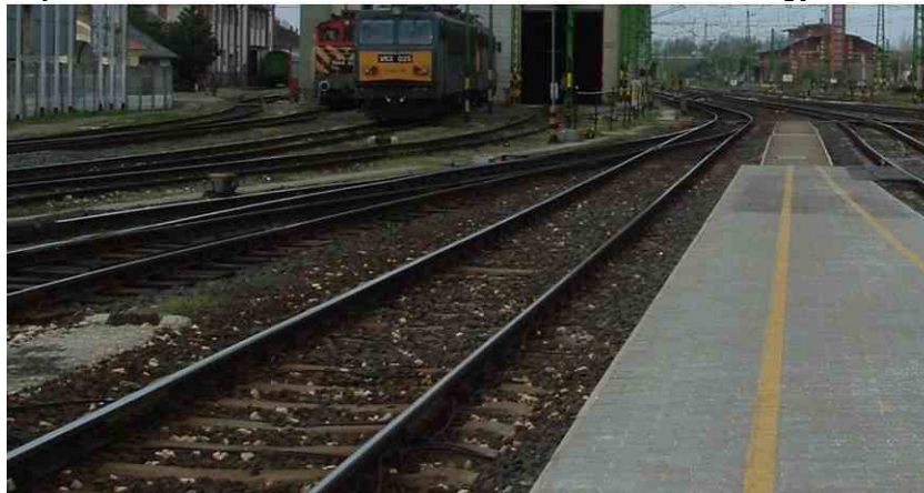
7. ábra Győr állomás V. vágánya
